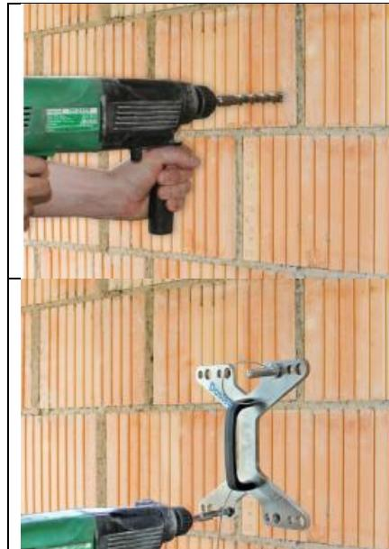
Erstes Bohrloch anzeichnen und bohren. Mauerwerke mit Lochsteinen ohne Schlag bohren.
