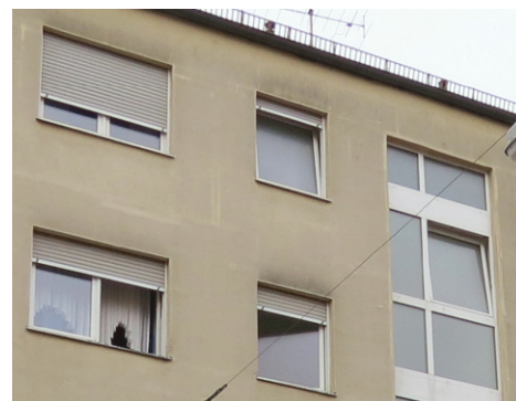
Ausschnitte der Nordfassade von Objekt 51, im Vergleich: 2014 (links) und 2022 (rechts), dort sind deutliche Ablaufspuren und helle Stellen entlang der Plattenstöße des WDV erkennbar. Der farbliche Unterschied der Fassaden ist durch unterschiedliche Aufnahmetechnik bedingt.
